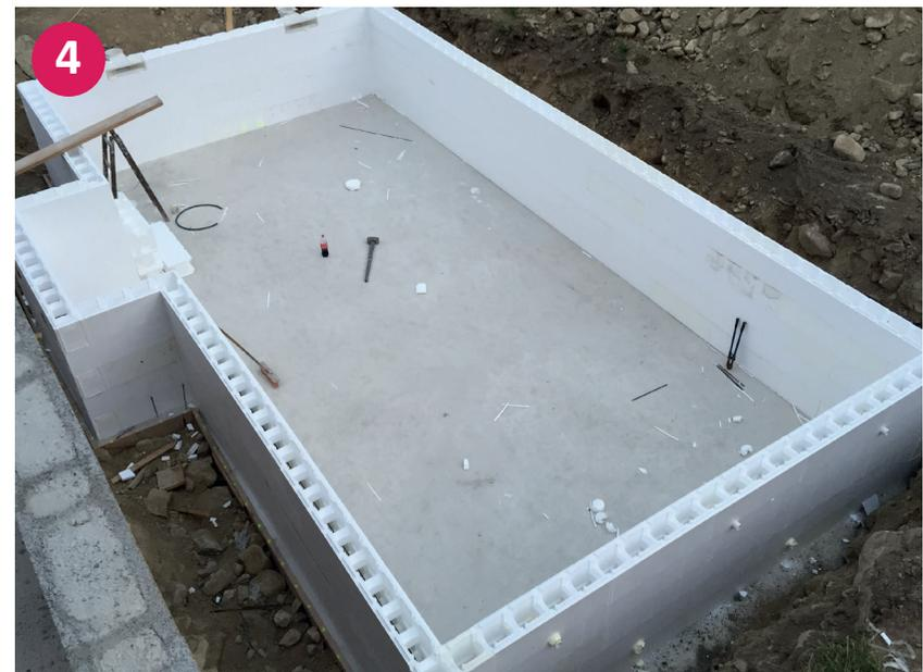
▲ Fertig aufgestelltes Styropor Becken – ohne Betonfüllung
