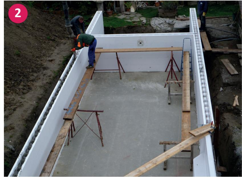
▲ Ausfüllen der Styroporstein mit dem Beton
