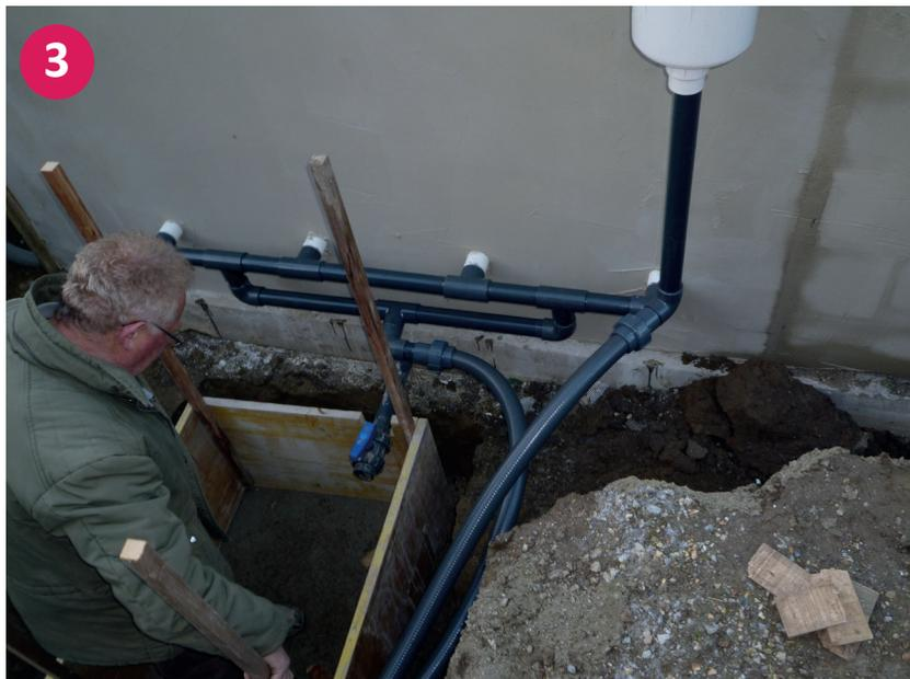
▲ Verrohrung von Düsen, Skimmer und Bodenablauf
