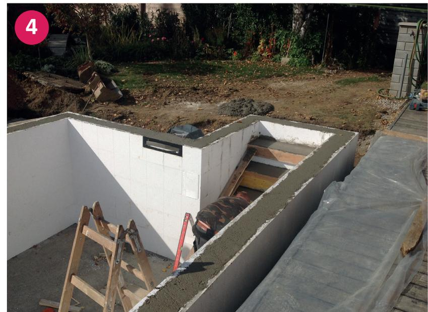
▲ Fertig ausgefülltes Styroporsteinbecken mit Beton
