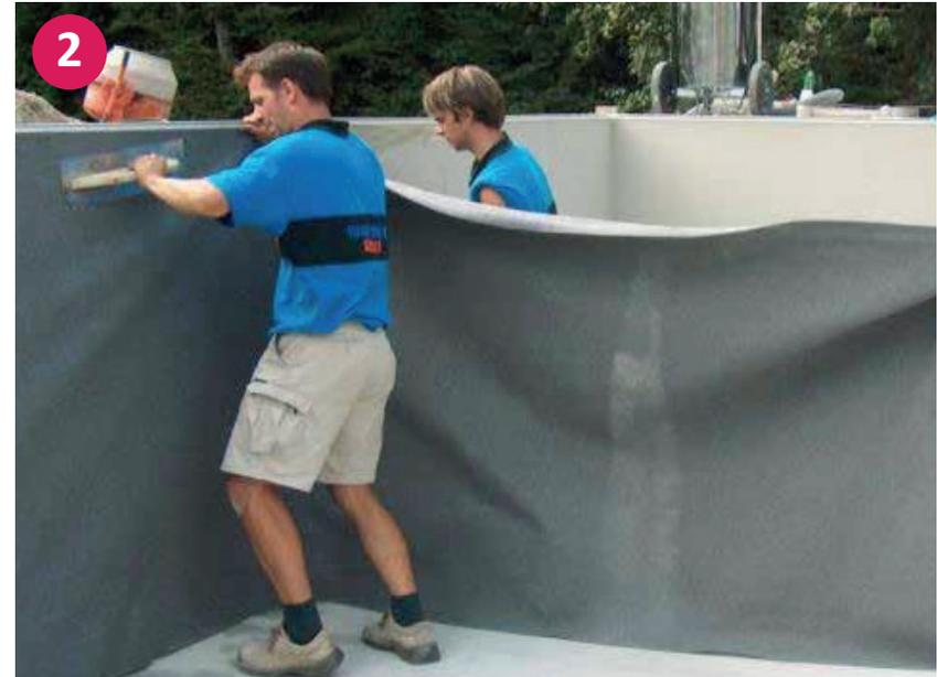
▲ Punktuelle Befestigung der Vliestrennlage mittels Styroporkleber
