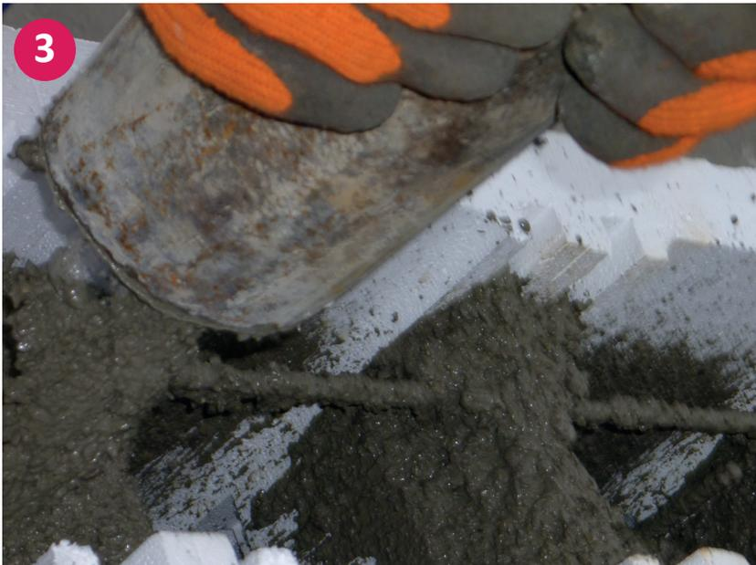
▲ Detailansicht: Ausfüllen der Styroporstein mit dem Beton
